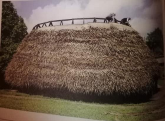
Alcuni spazi della capannone realizzati con una struttura di legno di
